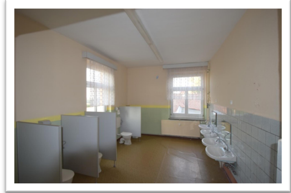
Abb. WC-Raum OG
